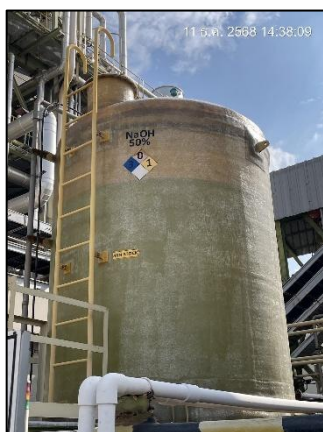
ภาพถ่ายที่ 2.2-27 ถังเก็บสารละลายโซเดียมไฮดรอกไซด์
