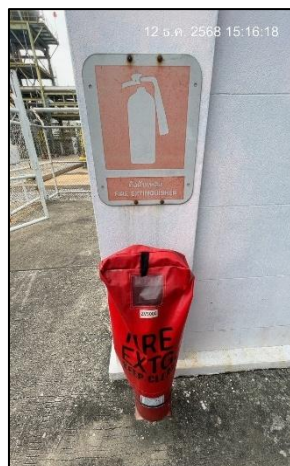
ภาพถ่ายที่ 2.2-37 เครื่องดับเพลิงชนิดผง (Powder Extinguisher) บริเวณสถานีควบคุมก๊าซ
