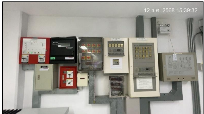
ภาพถ่ายที่ 2.2-32 ตู้ควบคุมสัญญาณเตือนต่างๆ
