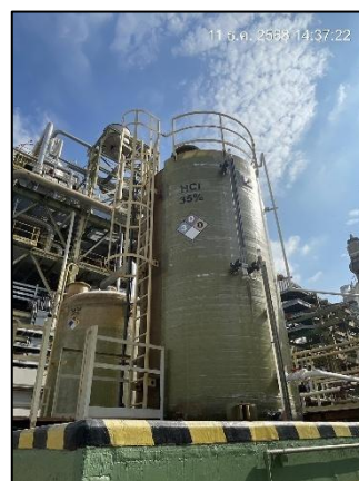
ภาพถ่ายที่ 2.2-28 ถังเก็บสารละลายกรดไฮโดรคลอริก
