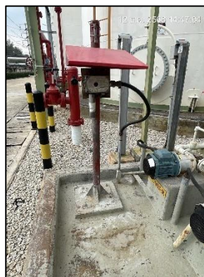
ภาพถ่ายที่ 2.2-31 Gas Detector และ Ammonia Detector
