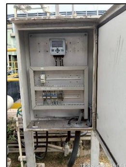
ภาพถ่ายที่ 2.2-4 การติดตั้งเครื่องมือตรวจวัดคุณภาพน้ำอัตโนมัติ
