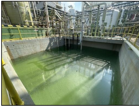
ภาพถ่ายที่ 2.2-5 ถังปรับสภาพ (Neutralization Basin)
