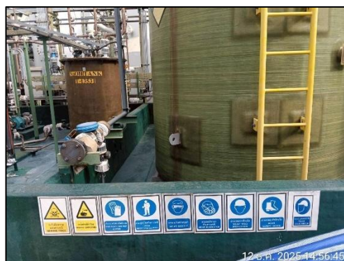
ภาพถ่ายที่ 2.2-26 คันคอนกรีตป้องกันการหกรั่วไหลของสารเคมี
