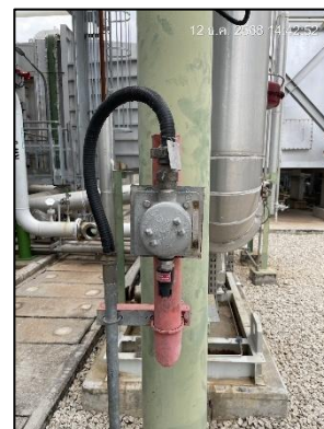
ภาพถ่ายที่ 2.2-31 Gas Detector และ Ammonia Detector
