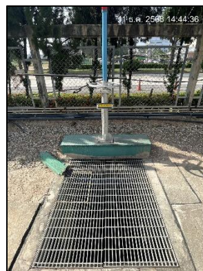
ภาพถ่ายที่ 2.2-9 ประตูละบายน้ำของรางระบายน้ำฝน
