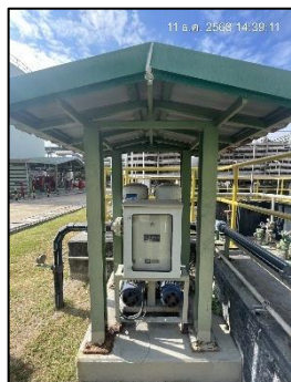
ภาพถ่ายที่ 2.2-3 การติดตั้งอุปกรณ์เพื่อนำน้ำทิ้งกลับมาใช้ประโยชน์
