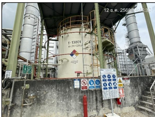
ภาพถ่ายที่ 2.2-30 ถังเก็บสารละลายแอมโมเนียมไฮดรอกไซด์
