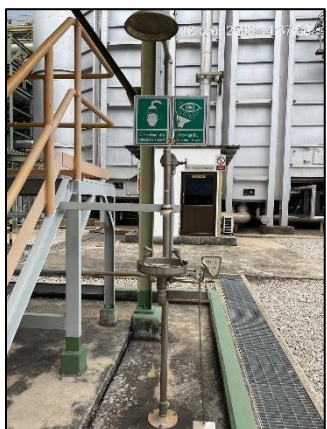
ภาพถ่ายที่ 2.2-25 อ่างล้างตาและฝักบัวฉุกเฉิน
